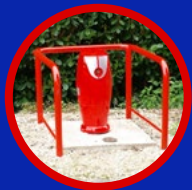
Poteau Incendie (PI)
